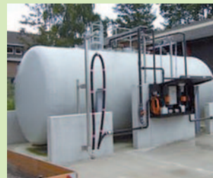
Cuve complémentaire de stockage de saumure 10.000 L. avec dispositif de chargement pour plusieurs véhicules
